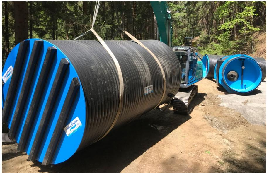
Zwei Hochbehälter mit 50m<sup>3</sup> Fassungsvermögen und mittiger Schieberkammer erhöhen die Versorgungssicherheit mit Trinkwasser in Bruck/Mur.
